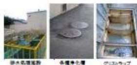
排水処理施設、浄化槽での使用例
