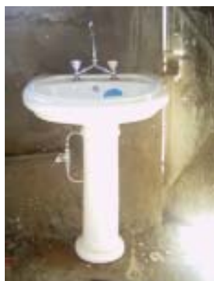
修理された洗面台
