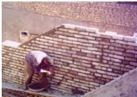
空爆により崩壊した壁の修理： 再建前（上） 再建中（下）
