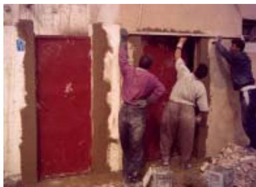
バグダッド市：老朽化した扉の修復中の様子
